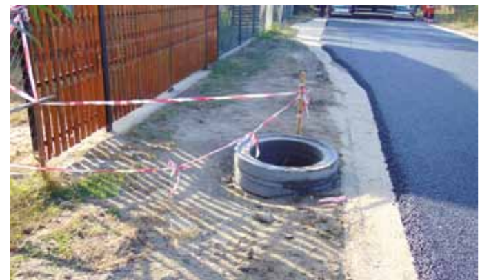
József A. út vízvezeték, aszfaltozás 2018.
