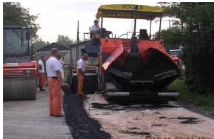
A Tiszai út aszfaltozása 2007-ben
